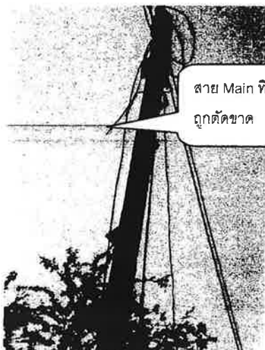
รูปที่ 3 สายไฟฟ้า Main จากการไฟฟ้าภูมิภาคก่อนเข้ามิเตอร์ตรวจวัดถูกตัดขาด
