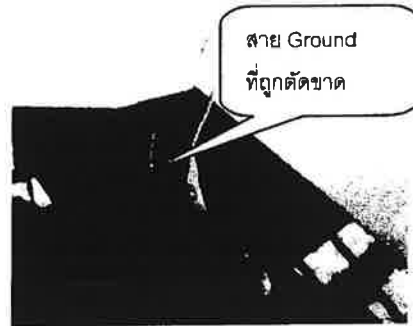
รูปที่ 5 สาย Ground ที่ถูกตัดขาด
